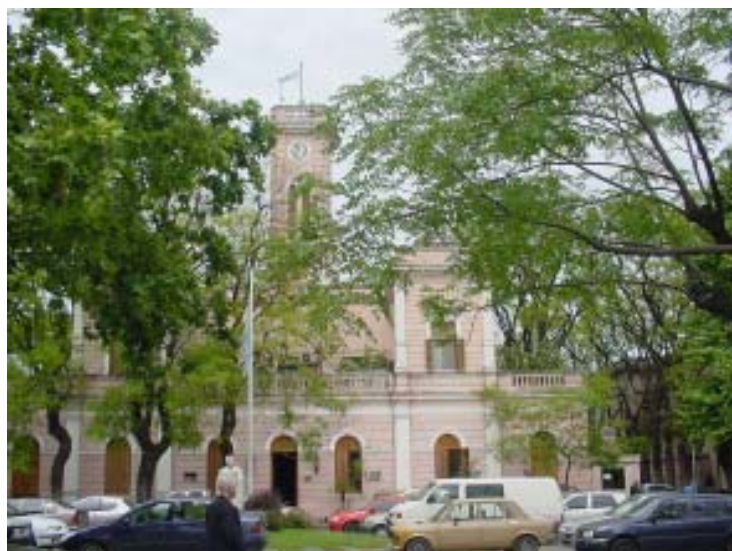
Figura 28: Antiguo edificio de la Administración de los Mataderos , 2004.
